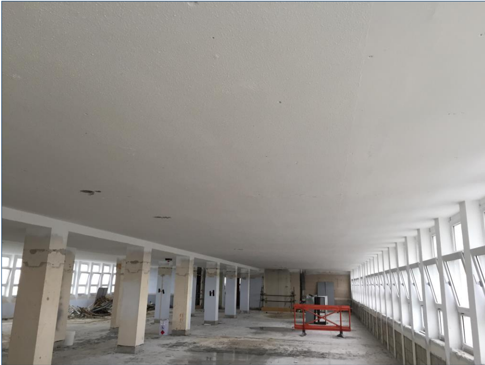
Mjuka betongplattor skyddade med AITHON A90H
